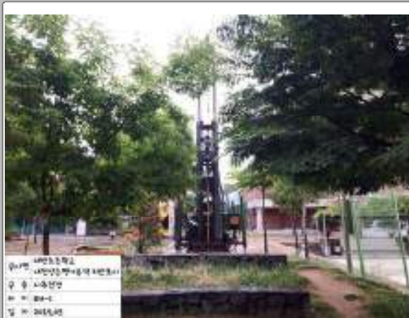
사진설명 : BH-2 작업전경(원거리)
