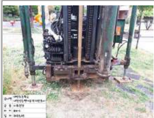
사진설명 : BH-2 작업전경(근거리)
