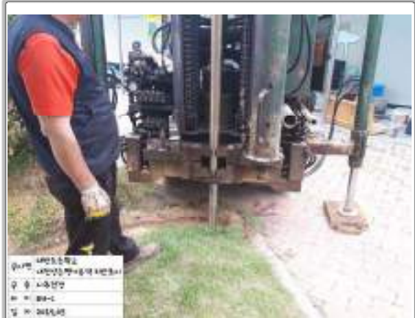
사진설명 : BH-1 작업전경(근거리)
