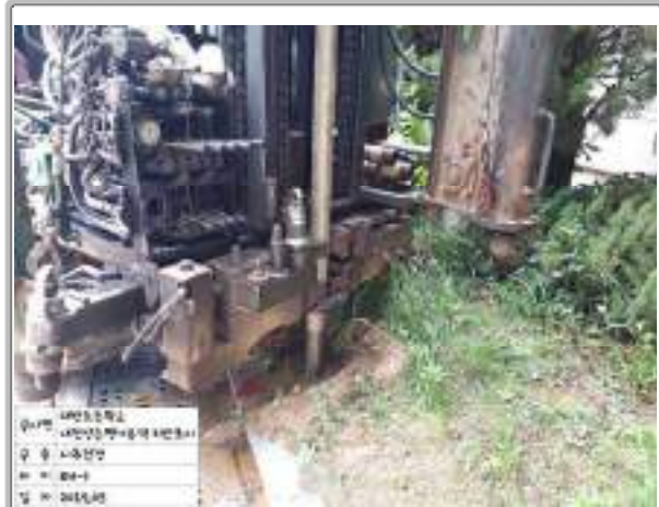
사진설명 : BH-3 작업전경(근거리)
