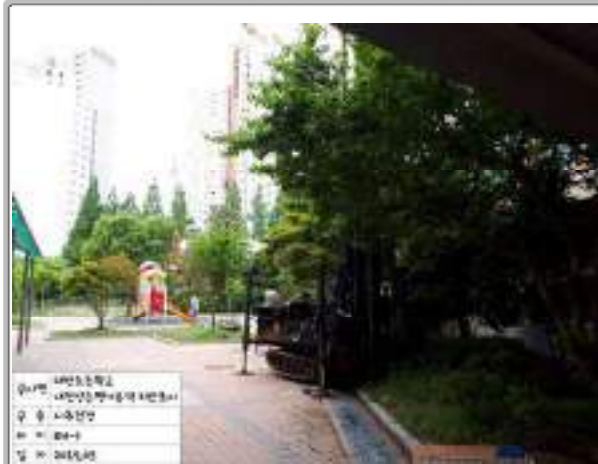
사진설명 : BH-3 작업전경(원거리)
