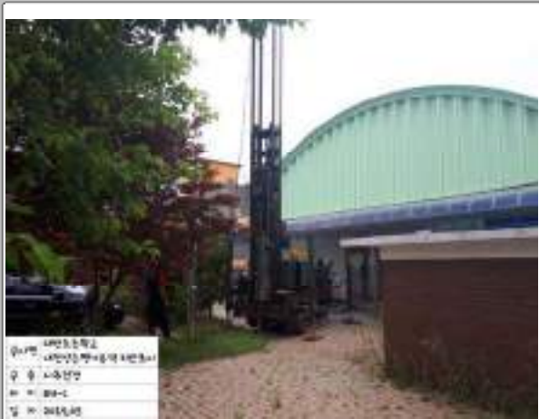
사진설명 : BH-1 작업전경(원거리)
